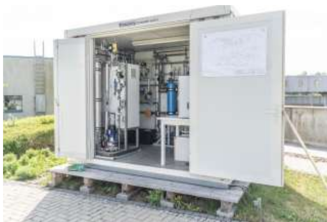
Переносная установка для обработки сточных вод со встроенной аналитической системой ANTHROPLAS
